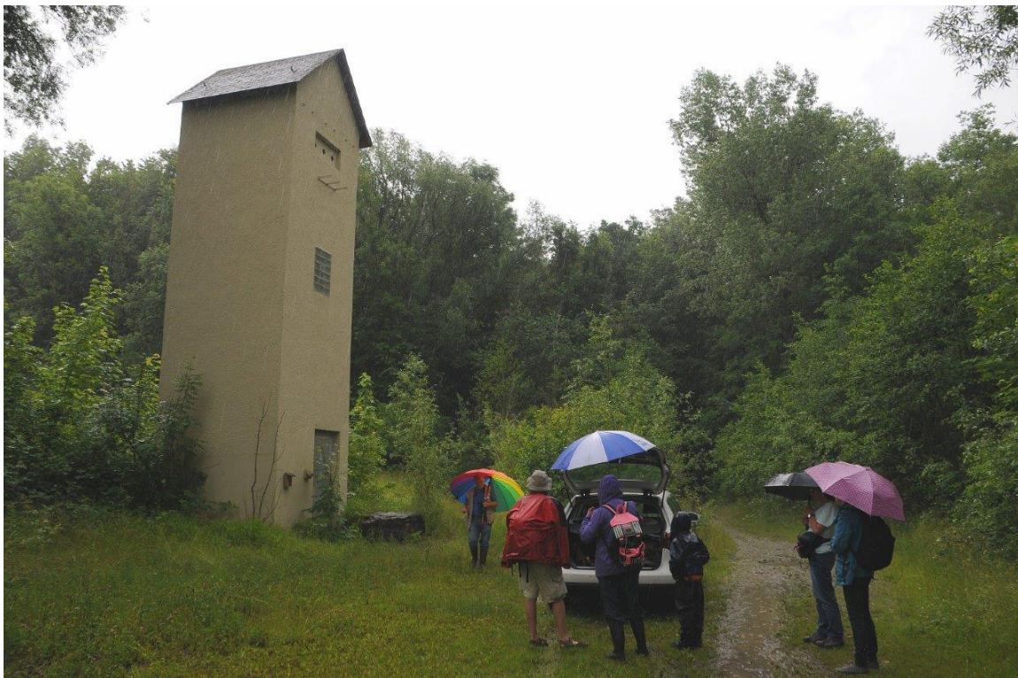
Warten auf ein Ende des starken Regengusses am Trafohaus
