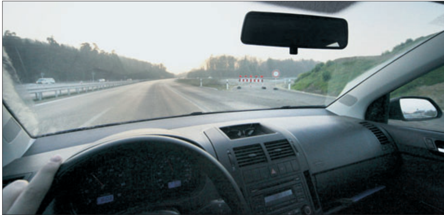
Ausfahrt Winnenden Süd: Eine Sperrung verhindert den schnellen Weg von Leutenbach ins Lange Gewand.
