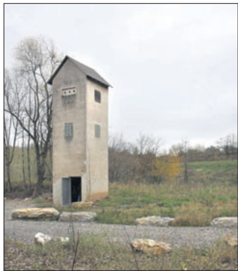
Das ehemalige Traföhäuschen. Bild: Pavlović
