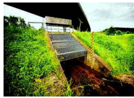
Der Durchlass im Hochwasserdamm unter der Schornbachtalbrücke. Foto: Gottfried Stoppel
